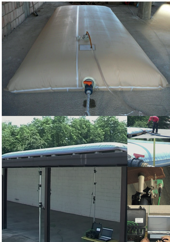
Figura 1 - Particolari di una prova di carico su solai con messa in carico a mezzo serbatoio ripiegabile, rilievo delle frecce mediante sensori di spostamento elettronici centesimali fissati per mezzo di aste telescopiche ed acquisiti per mezzo di centralina elettronica da campo T-Test K12.
