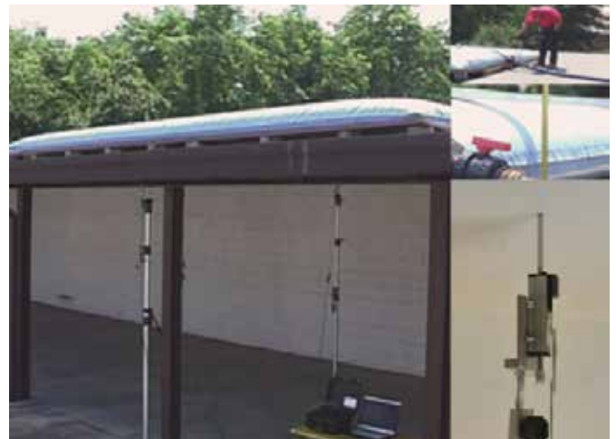
Figura 2 - Applicazione per prova di carico
