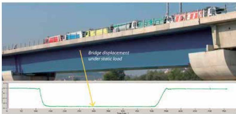
Fig. 3: IBIS-FS monitoraggio statico di un ponte
