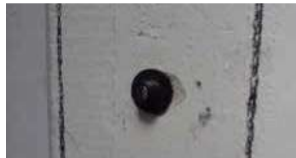
Fase 6: battitura meccanica della capsula cilindrica all'interno del tassello
