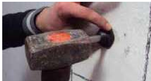
Fase 6: battitura meccanica della capsula cilindrica all'interno del tassello
