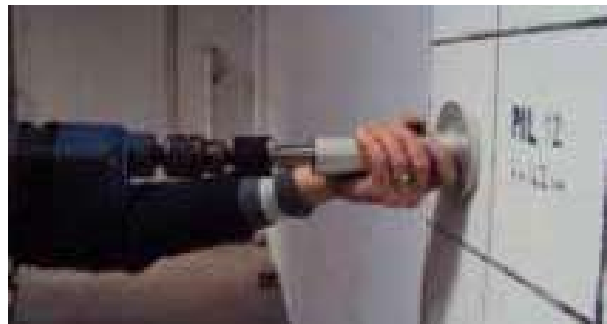
Fase 3: esecuzione perforazione con punta al widia \varnothing 18 mm
