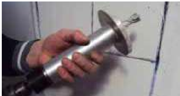
Fase 3: esecuzione perforazione con punta al widia \varnothing 18 mm
