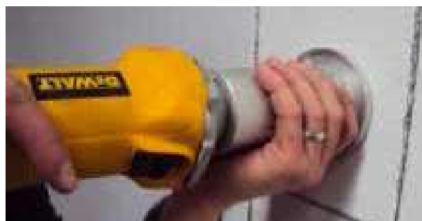
Fase 4: esecuzione alesaggio con fresa diamantata \varnothing 18 mm
