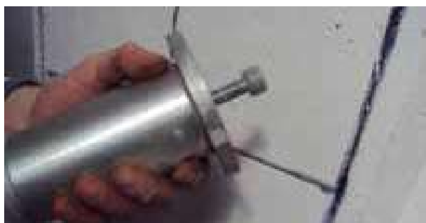
Fase 4: esecuzione alesaggio con fresa diamantata \varnothing 18 mm
