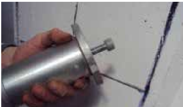
Fase 4: esecuzione alesaggio con fresa diamantata ø 18 mm
