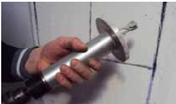
Fase 3: esecuzione perforazione con punta al widia ø 18 mm
