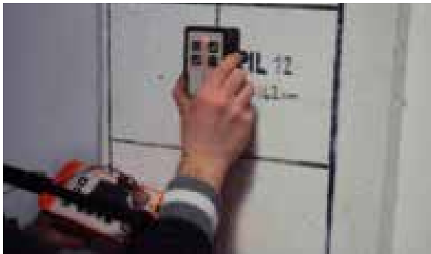
Fase 1: esecuzione indagine magnetometrica
