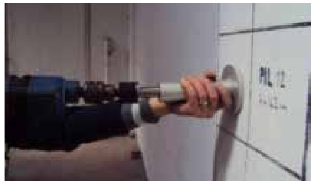
Fase 3: esecuzione perforazione con punta al widia ø 18 mm
