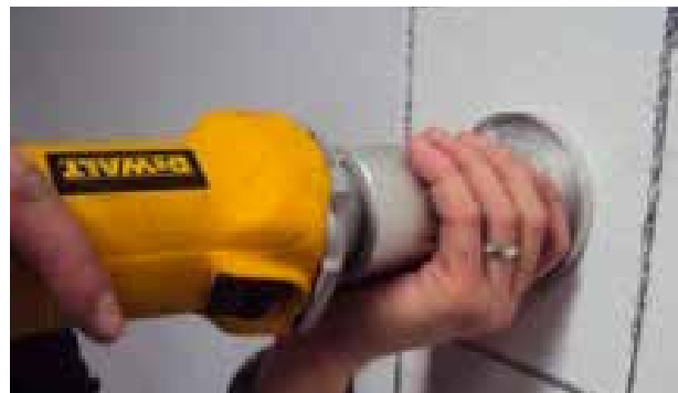
Fase 4: esecuzione alesaggio con fresa diamantata ø 18 mm
