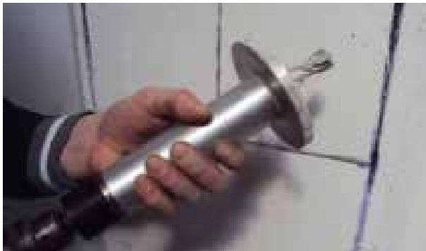
Fase 3: esecuzione perforazione con punta al widia \varnothing 18 mm
