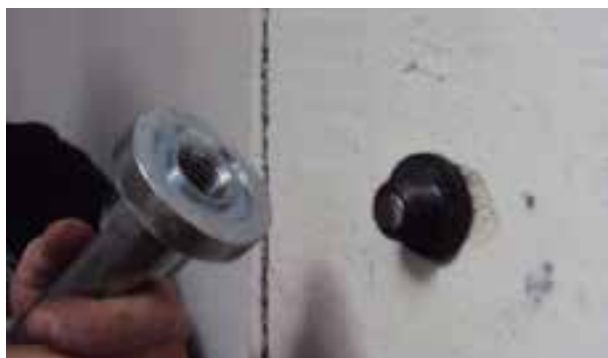
Fase 7: avvitamento dello stelo estrattore del martinetto oleodinamico alla filettatura del tassello
