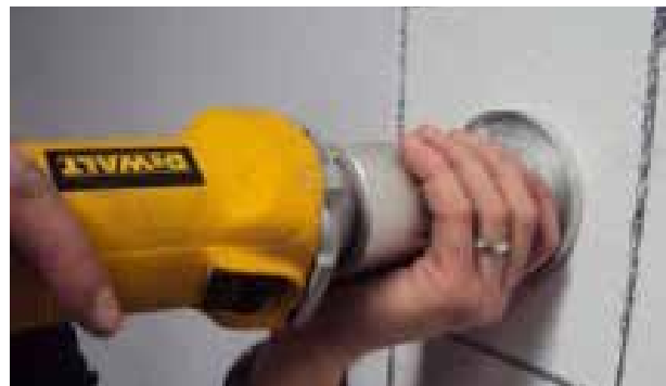
Fase 4: esecuzione alesaggio con fresa diamantata \varnothing 18 mm
