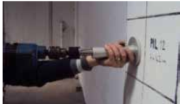
Fase 3: esecuzione perforazione con punta al widia \varnothing 18 mm
