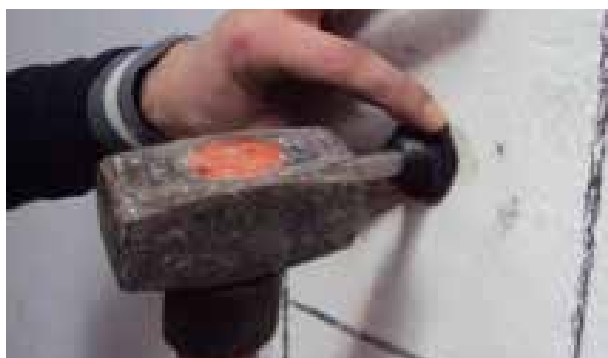
Fase 6: battitura meccanica della capsula cilindrica all'interno del tassello
