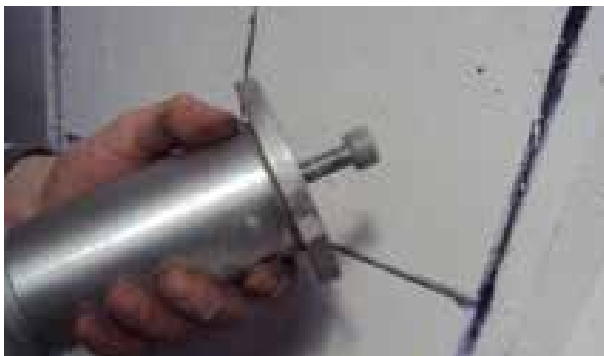
Fase 4: esecuzione alesaggio con fresa diamantata \varnothing 18 mm
