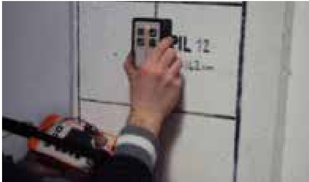
Fase 1: esecuzione indagine magnetometrica
