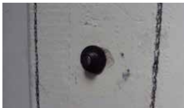
Fase 6: battitura meccanica della capsula cilindrica all'interno del tassello
