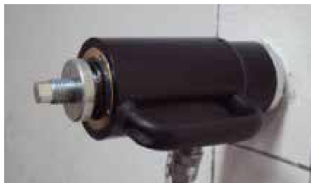
Fase 8: posizionamento e fissaggio del martinetto e collegamento del tubo idraulico alla pompa
